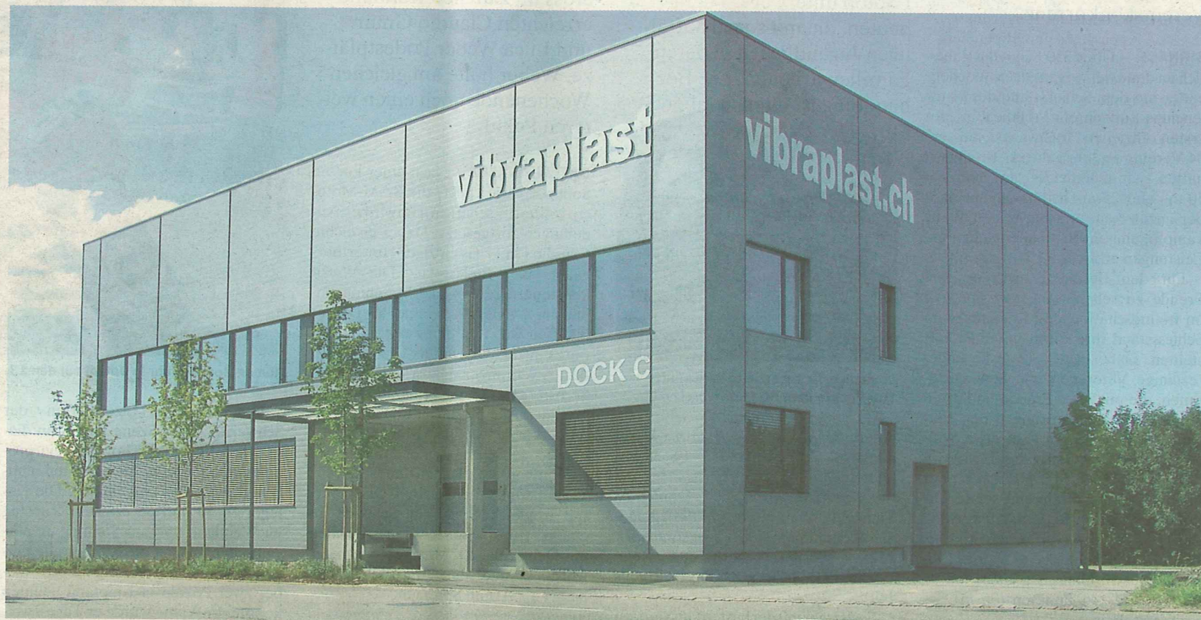
Nach einem knappen Jahr Bauzeit konnte im Juni dieses Jahres die Produktions- und Lagerhalle Dock C der Vibraplast in Aadorf bezogen werden. Bilder: zvg
